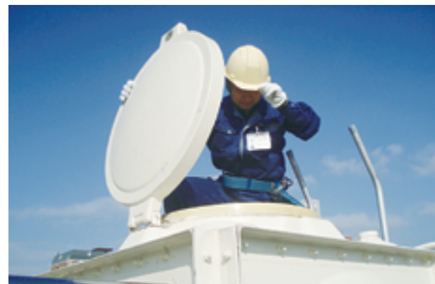
■写真-1: 受水槽点検作業
