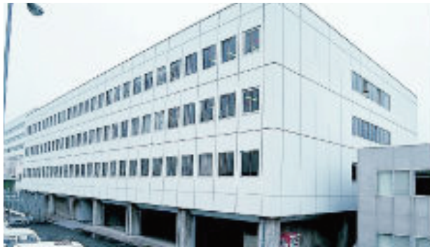
■第2貨物代理店ビル(成田国際空港株式会社 提供)
