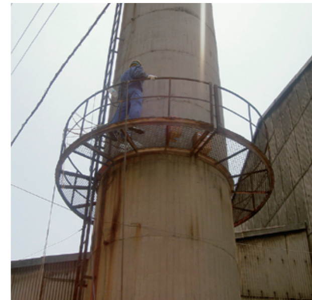
■ガラス溶融炉煙突のばい煙測定
